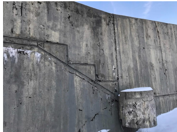
Mynd 29: Veðurhlíf fyrir loftræsingu telst ónýt
