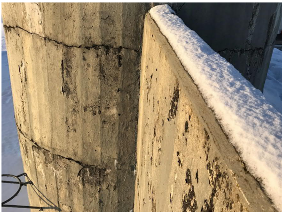
Mynd 52: Sprungur á steypuskilum eru stórar
