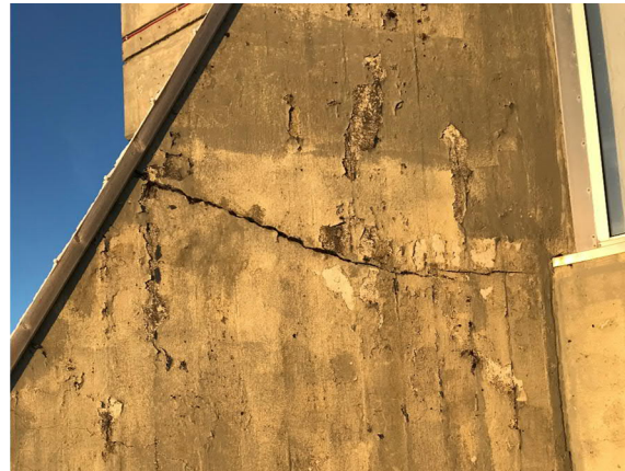
Mynd 17: Kaldur veggur sprunginn og gljúpur
