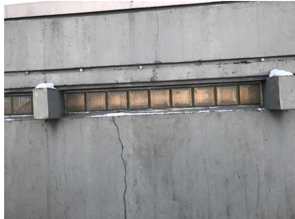
Mynd 7: Djúpar sprungur vestur af aðalinngangi
