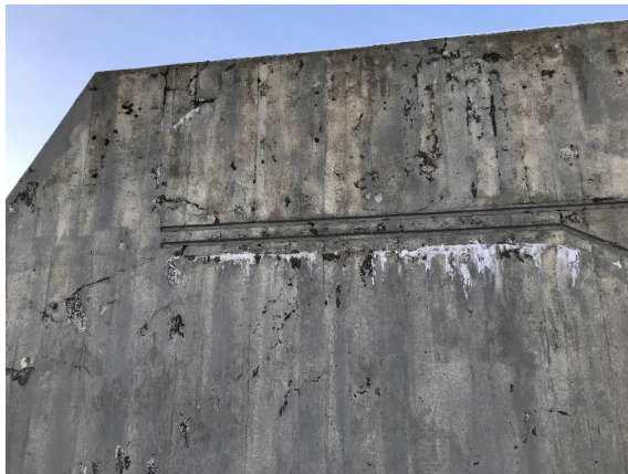
Mynd 28: Sprungið yfirborð og kalkútfellingar
