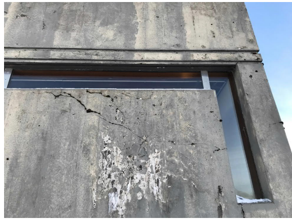
Mynd 33: Sprungumyndun og kalkútfellingar
