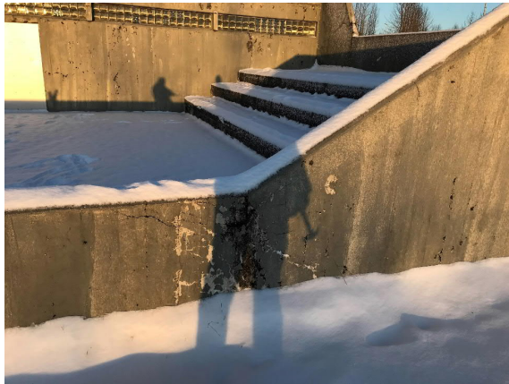
Mynd 60: Sprungur á steypuskilum
