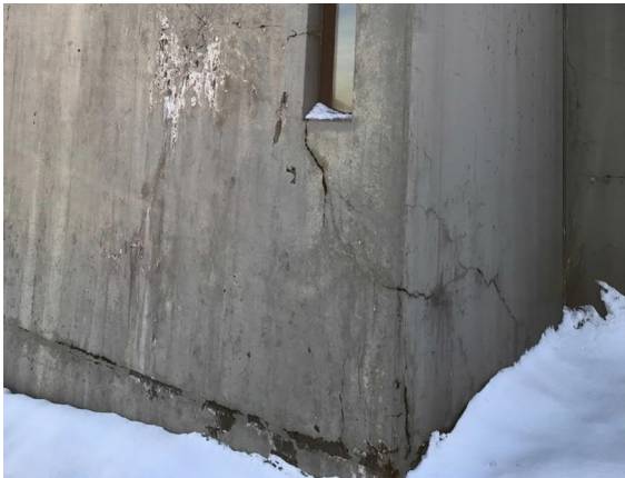
Mynd 34: Skemmdir á plötuskilum botnplötu
