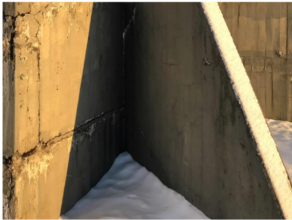
Mynd 16: Skemmdir á plötuskilum botnplötu
