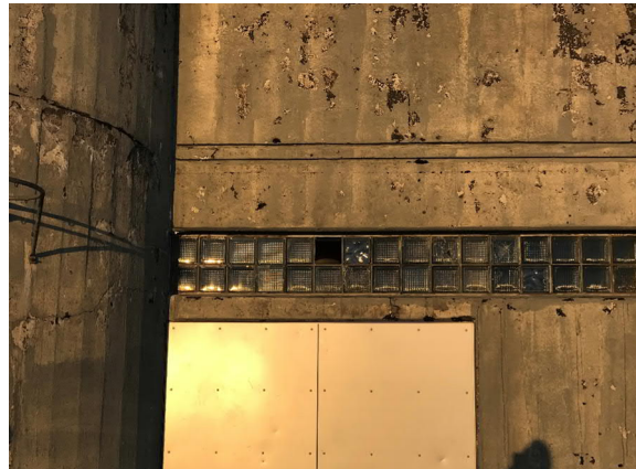
Mynd 43: Hleðslugler vantar á sumum stöðum
