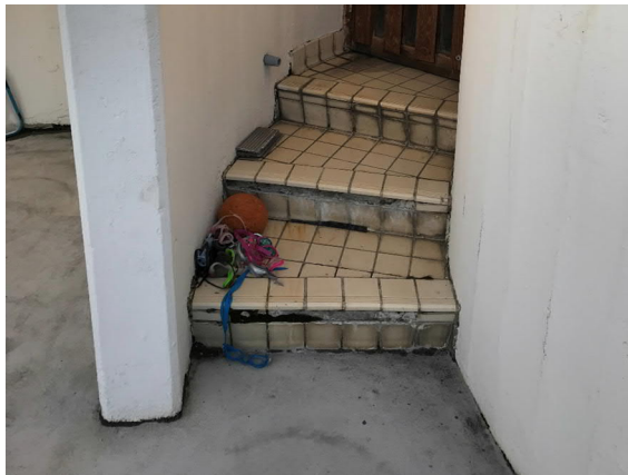
Mynd 44: Flísalögn á tröppum telst ónýt
