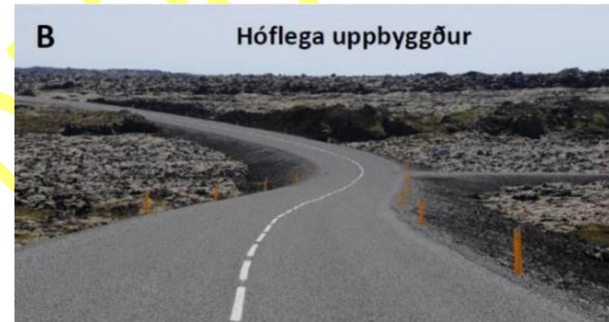
MYND 32. Sviðsmynd B. Hóflega uppbyggðir vegir sem felldir verða að landslagi og með bundnu slitlagi.
