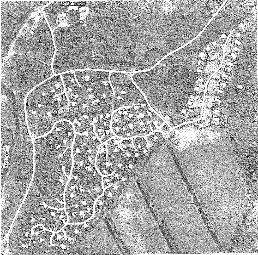
Mynd 1. Loftmynd af hjólhýsasvæðinu við Skriðufellsnes (Loftmyndir ehf.).
