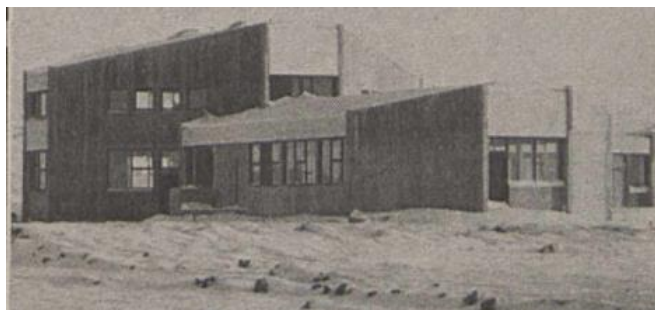
Nýja skólahúsið í byggingu haustið 1982.
